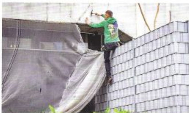
Zur Substanzerhaltung finden zurzeit Bauarbeiten am Opernhaus statt.
