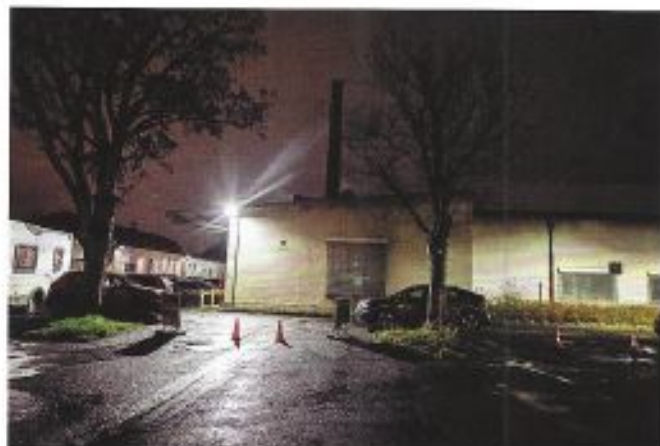
Das Gelände in Beuel: jetzt eine abtrissreife Halle, bald Standort von Oper und Schauspiel?
